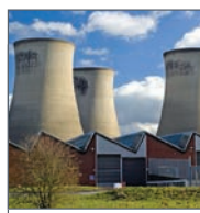
Boilere și cazane
